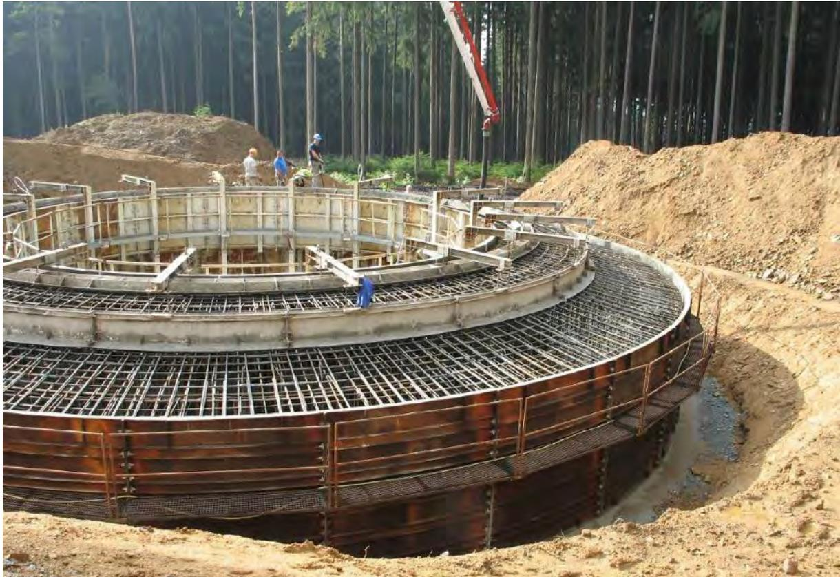
Abb. 1: Beispiel für den Bau eines Flachfundaments einer Windenergieanlage, /1/
