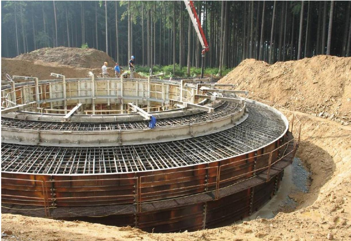
Abb. 1: Beispiel für den Bau eines Flachfundaments einer Windenergieanlage, 1/1
