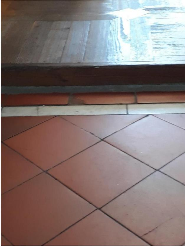
Bild 14: Höhenunterschied Stolperkanten Fußboden
