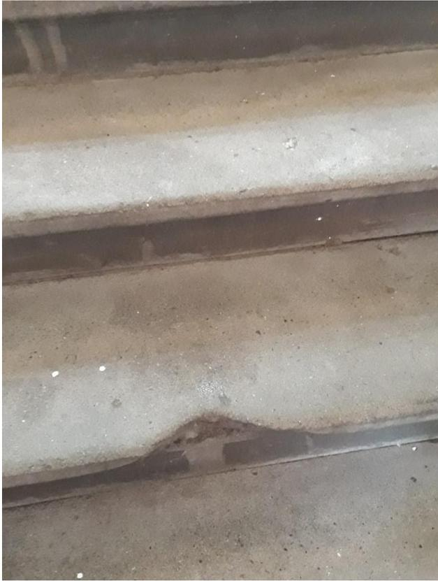
Bild 20: Schadhafte Stufe Treppenhaus
