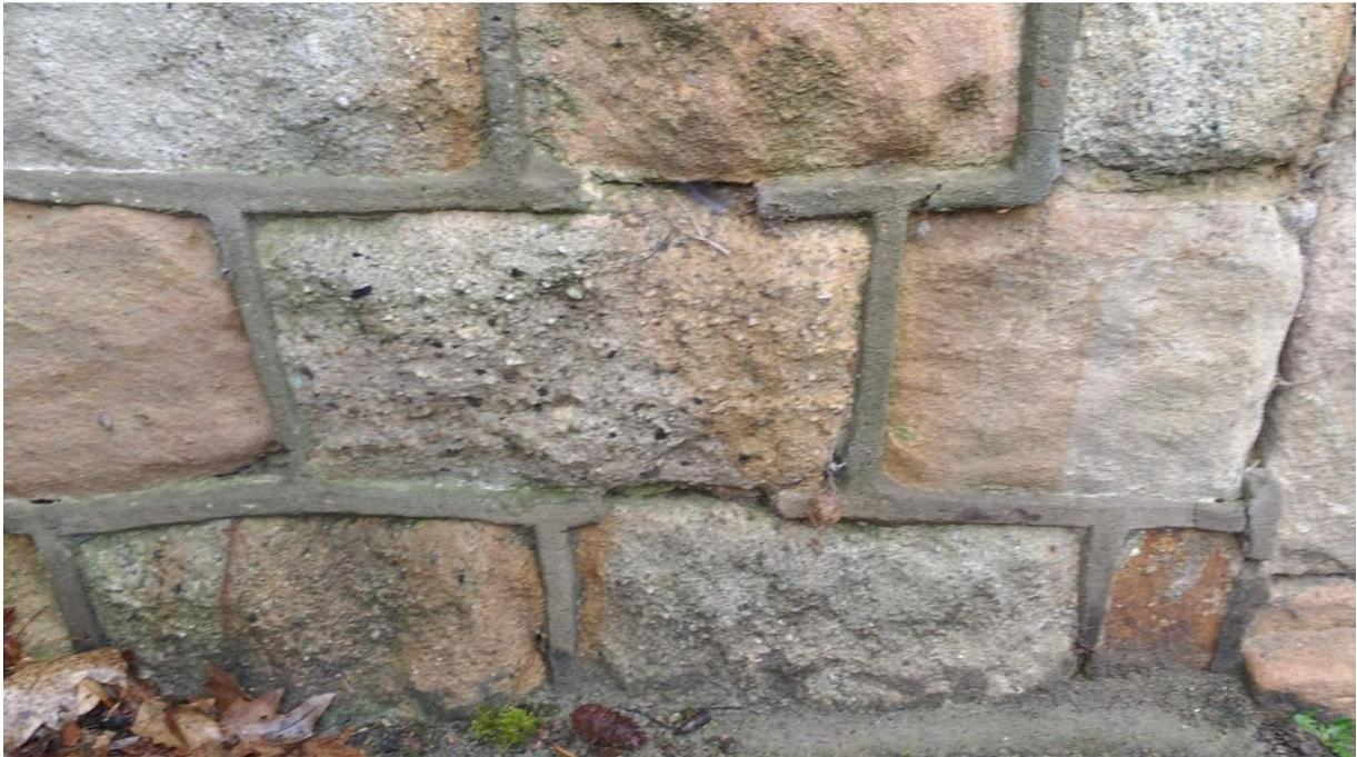
Bild 5: Fugenbild Sandsteinmauerwerk
