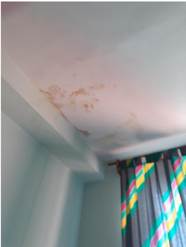
Bild 20: Wasserflecken Decken
